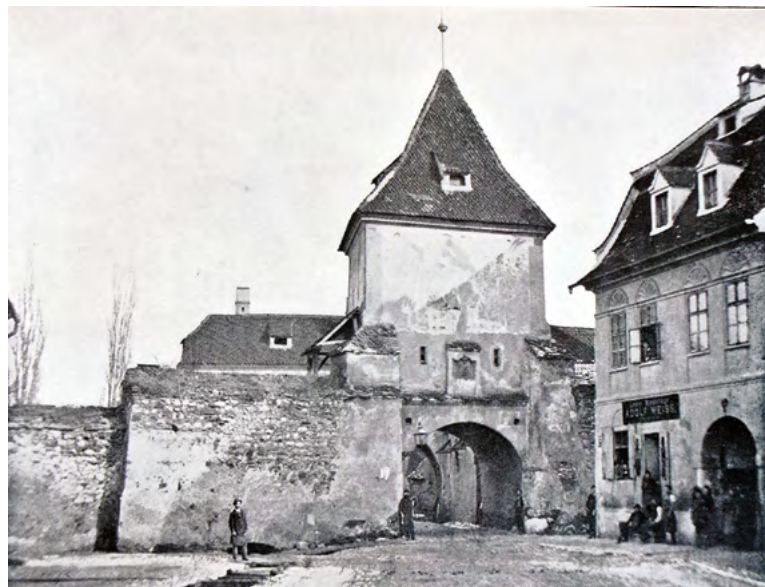
Turnul Porții Străzii Negre, care se afla pe linia primului zid de incintă al cetății. A fost demolat în anul 1873 (După Kronstadt III, il. 122.)
