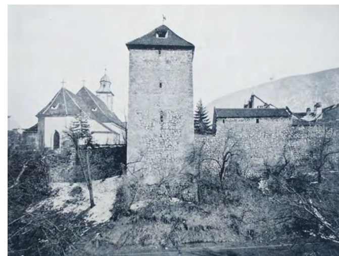
Zidul și unul dintre turnurile de pe latura de nord-vest a cetății
